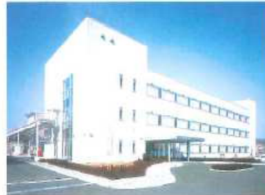
发动机研究楼 อาคารวิจัยเครื่องยนต์
